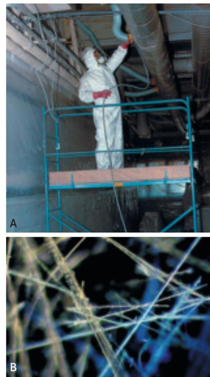
Fig. 2.17 L'isolation par l'amiante est courante dans les constructions et présente un danger lors de la démolition. (A) Des vêtements de protection doivent être portés pour éviter tout contact avec (B) les fibres d'amiante.
